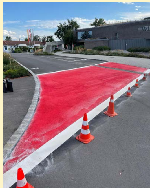
Markierung eines Übergangs mit Plasti Route Rollplast
